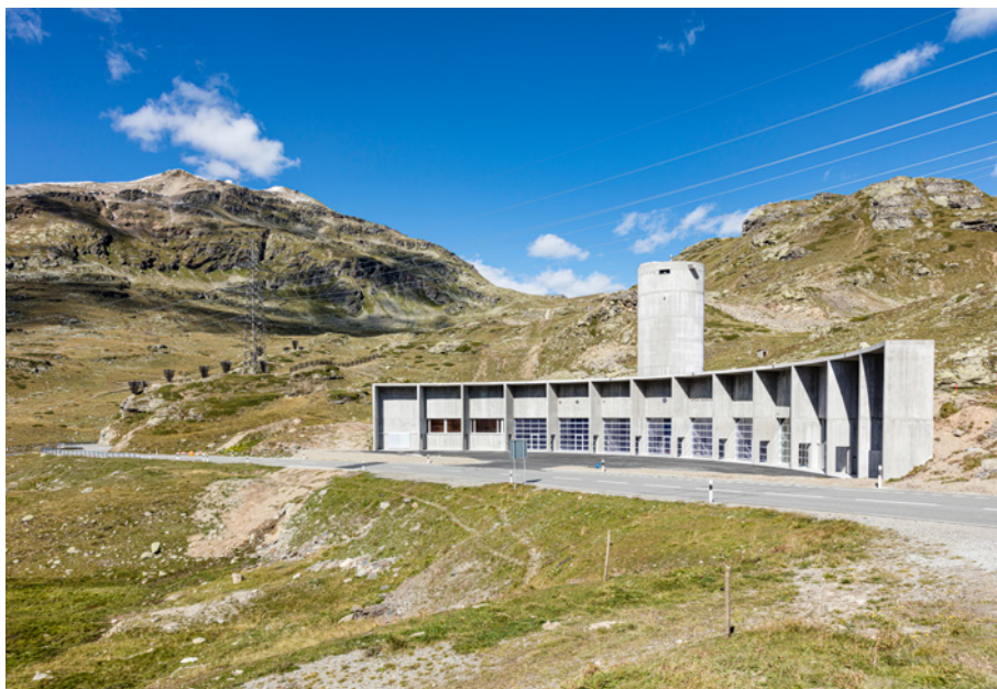
Die Vielfalt an Tätigkeiten innerhalb der Verwaltung entspricht 39 KMU! Hier der Unterhaltstützpunkt Bernina des Tiefbauamtes.
